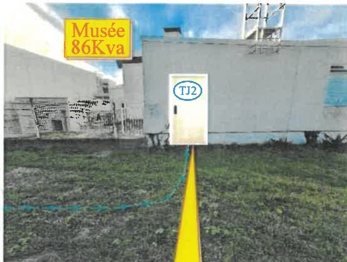
Armoire TJ à poser en saillie devant mur (h=1400xlarg:1050xProf:435mm)
