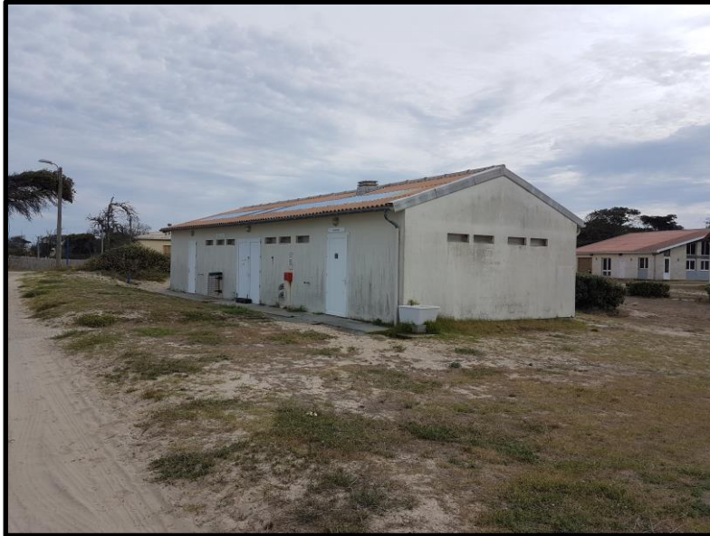
Bâtiment à désamianter et à démolir en 2023 (photographie : CdC Médoc Atlantique 2019).
