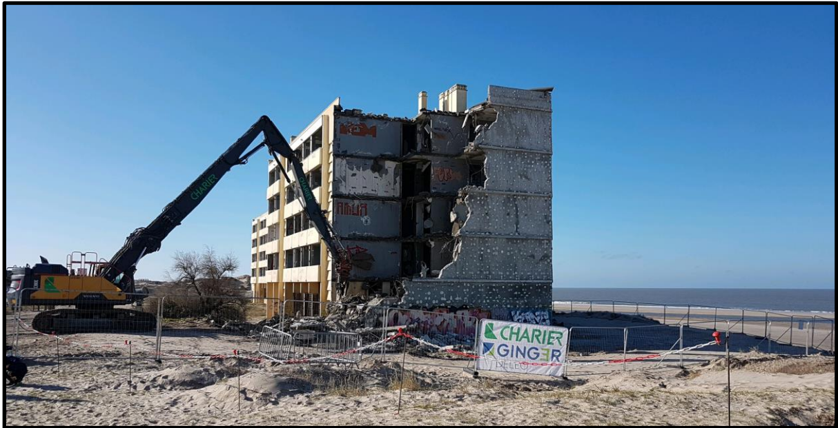
Travaux de démolition de l'immeuble « Le Signal » (photographie CdC Médoc Atlantique du 06 février 2023).
